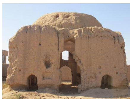
تصویر ۷: پوشش نعل درگاه به صورت تیغه‌ای در ضلع شمالی بنا (همان)
