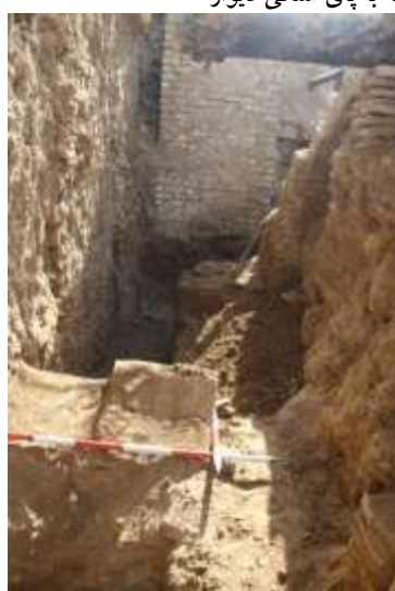
خروجی آب قنات آران دشت از حوضخانه
