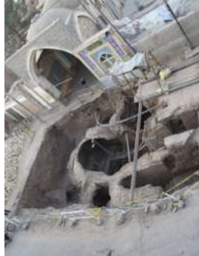
مسجد زیرزمینی و گذر سرکوچه یخچال در جانب شمالی حوضخانه (تصویر از نمای جنوبی)
