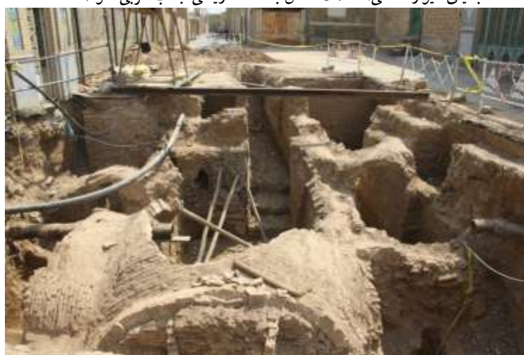
بنای حوضخانه از نمای غربی
