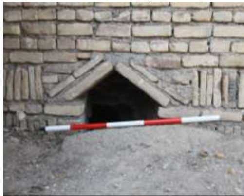
ورودی آب حوضخانه مسجد محله بازار
