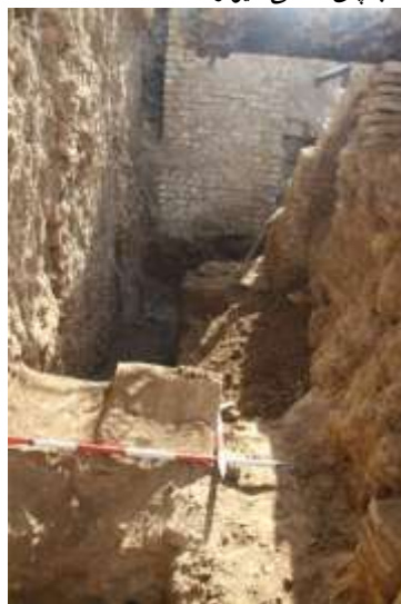
خروجی آب قنات آران دشت از حوضخانه
