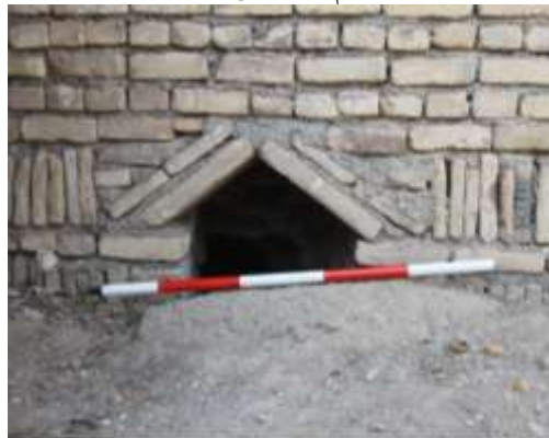
ورودی آب حوضخانه مسجد محله بازار
