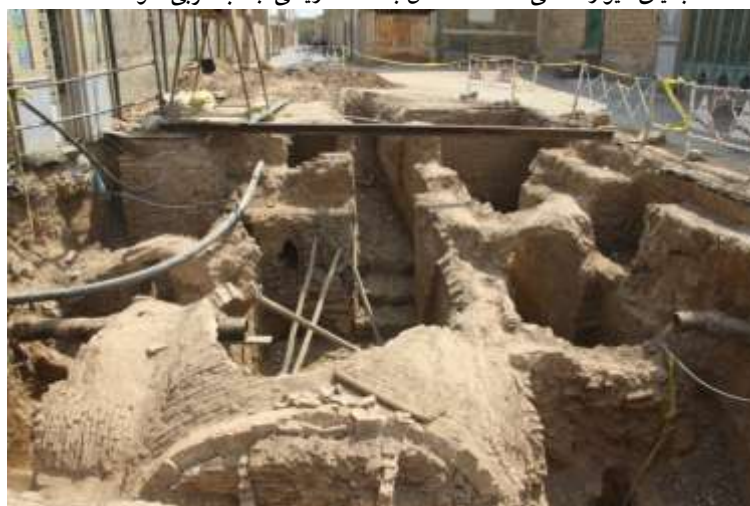
بنای حوضخانه از نمای غربی
