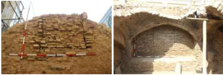
دریچه پرشده در جانب غربی حوضخانه (تصویر راست: نمای داخلی؛ تصویر چپ: نمای بیرونی)
