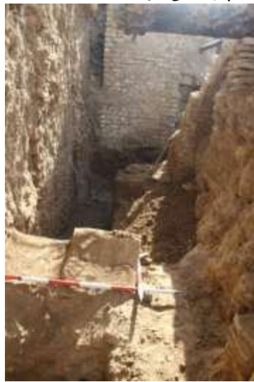
خروجی آب قنات آران دشت از حوضخانه
