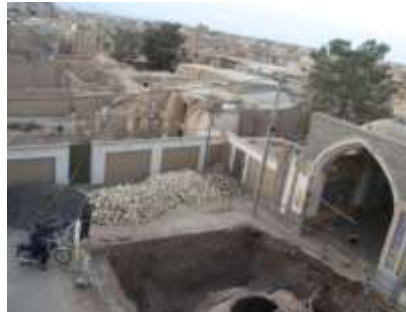
ضلع غربی حوضخانه از نمای جنوبی
