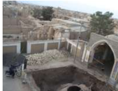
ضلع غربی حوضخانه از نمای جنوبی
