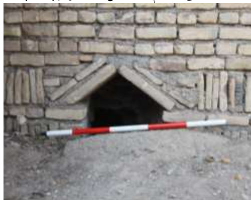
ورودی آب حوضخانه مسجد محله بازار
