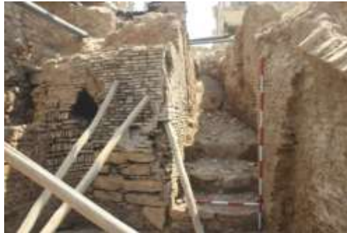
بدنه شرقی حوضخانه مردانه با پای سنگی دیوار
