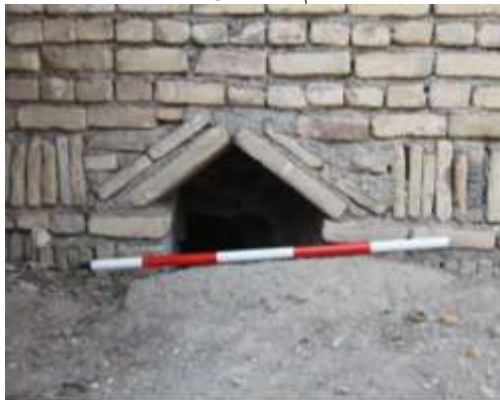
ورودی آب حوضخانه مسجد محلۀ بازار
