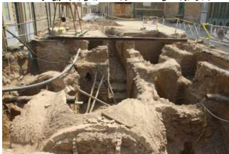
بنای حوضخانه از نمای غربی
