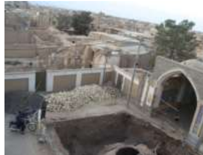
ضلع غربی حوضخانه از نمای جنوبی
