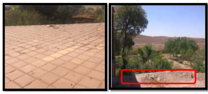
بام حوضخانه پس از مرمت بام حوضخانه پیش از مرمت
