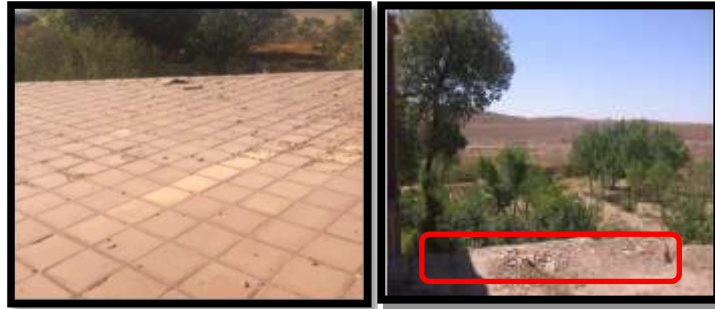
بام حوضخانه پس از مرمت
