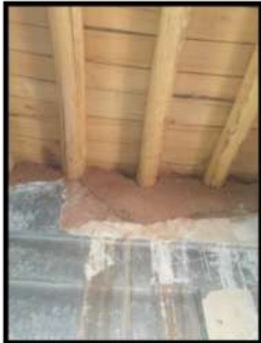
شکل ۱۹: بازسازی سقف شاه‌نشین
