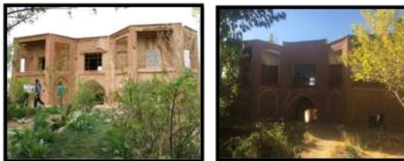
ضلع جنوبی کوشک پیش از مرمت
