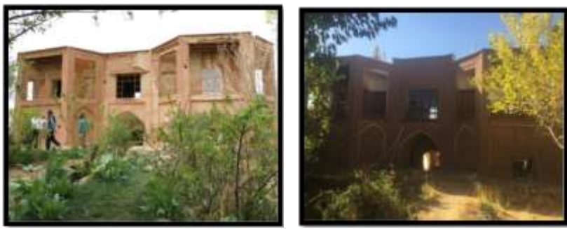
ضلع جنوبی کوشک پیش از مرمت ضلع جنوبی کوشک پس از مرمت
