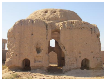
تصویر ۷: پوشش نعل درگاه به صورت تیغه‌ای در ضلع شمالی بنا (همان)
