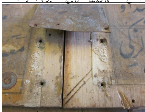
شکل (۹): نمایش پارچه چسبیده شده به چوب و زوار حلبی (نگارنده)
