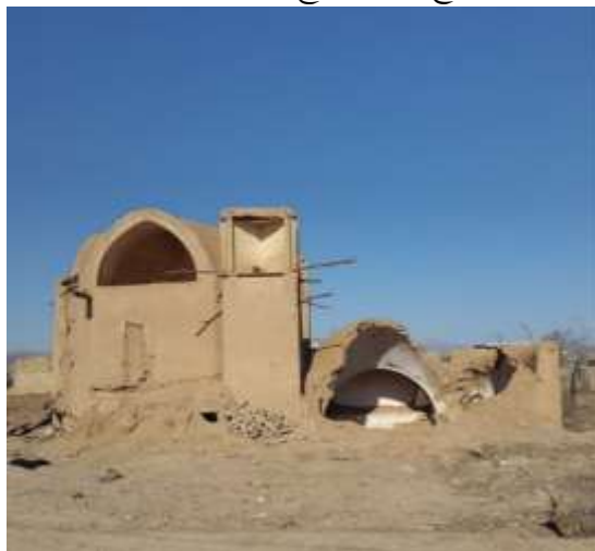
شکل ۲: تصویر حوضخانه تخریب شده باغ کاشانی (رضا نبی، ۱۳۹۴)
