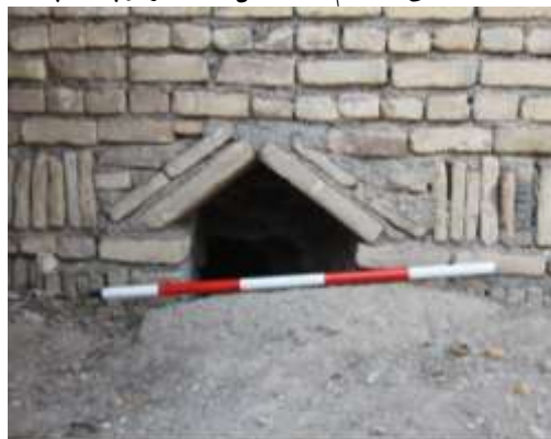
ورودی آب حوضخانه مسجد محلۀ بازار
