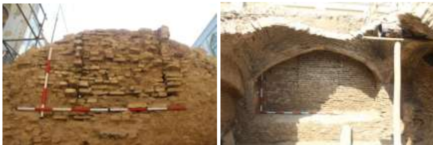
دریچه پرشده در جانب غربی حوضخانه (تصویر راست: نمای داخلی؛ تصویر چپ: نمای بیرونی)
