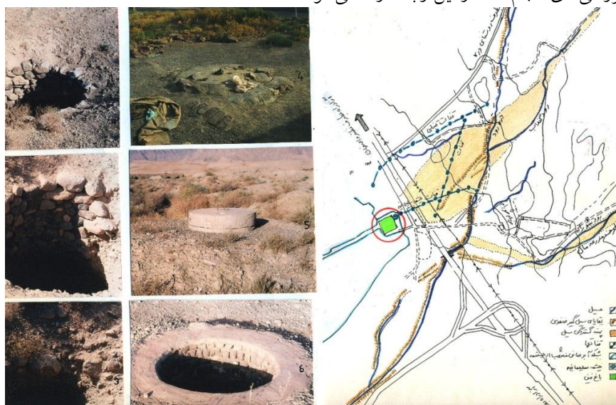
شکل ۷. سمت راست: موقعیت قنات‌ها و مسیل و عارضه‌های موجود در بالادست باغ فین و چشمه سلیمانیه؛ عکس‌های سمت چپ ۱ و ۲ و ۳ چاه‌های قنات تنبلی؛ ۴ و ۵ و ۶ چاه‌های قنات چشمه سلیمانیه (نقشه پایه: سازمان جغرافیایی) (مأخذ عکس‌ها و ترسیم‌ها نگارنده مقاله: ۱۳۸۸)
