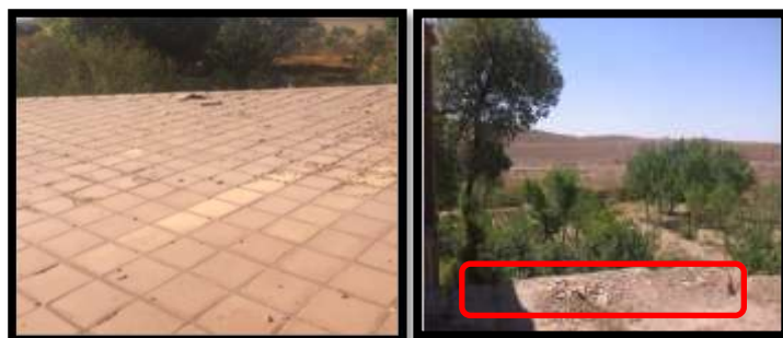
بام حوضخانه پس از مرمت
