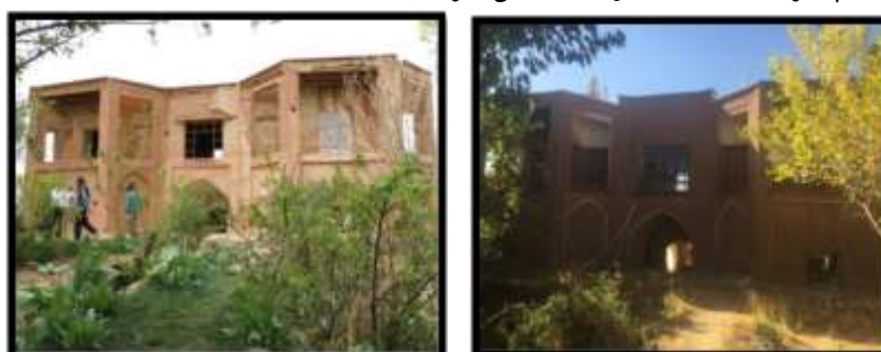
ضلع جنوبی کوشک پیش از مرمت
