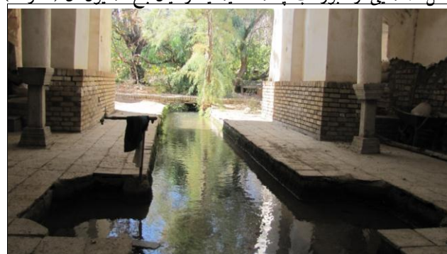
شکل ۹: نمایی از ورود آب از داخل باغ به فضا و صحن اصلی حوضخانه (نگارنده)
