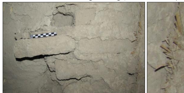
شکل ۱۴: خشت و ملات کاهگل دیوار (نگارنده)
