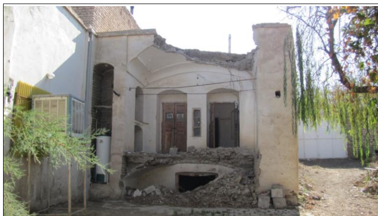
شکل ۱۰: نمایی از بنای قاجاری مجموعه (نگارنده)
