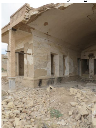
شکل ۷: اتاق‌های ضلع شرقی
