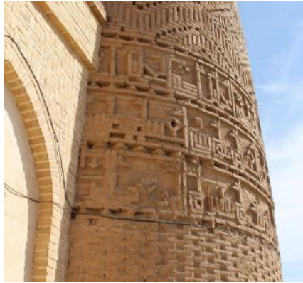
تصویر 15: اتصال مناره با بنا که منجر به مخدوش شدن بخش پایانی کتیبه شده است.
