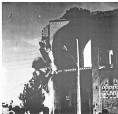
تخریب عمارت تلگرافخانه ۱۳۵۷
