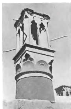
6. — Tour de ventilation de l'ab-anbar sis près de l'imam-zadeh Pendjé.
