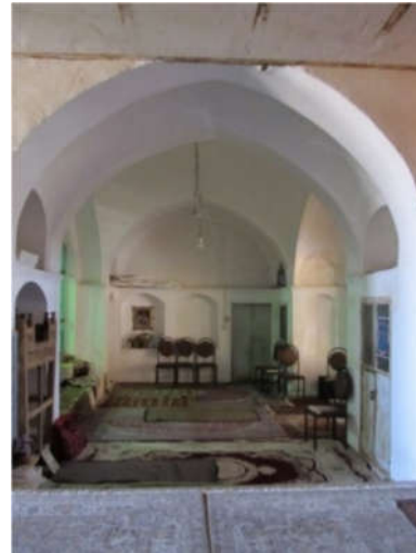
تصویر (۲۱): اتاق جانبی گنبدخانه (جنوب)
