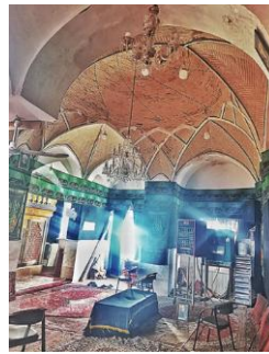
تصویر ۱۱: طاق چشمہ ای زیارتگاہ گلچقانہ با رسمی بندی منسوب بہ علی مریم و نمای جنوبی کہ طاق در میان گنبد مخروطی و منارہ پیداست
