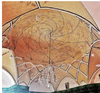
تصویر ۱۱: طاق چشمہ ای زیارتگاہ گلچقانہ با رسمی بندی منسوب بہ علی مریم و نمای جنوبی کہ طاق در میان گنبد مخروطی و منارہ پیداست
