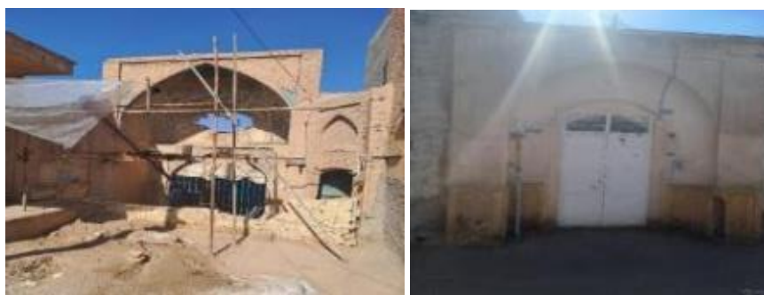
۷: نمای بیرونی آب انبار و حمام ملاها در مجاورت مسجد آقابزرگ و مجموعه خواجه تاج الدین
